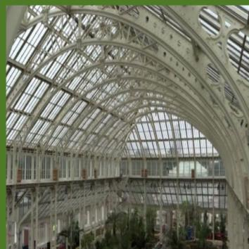
ESEMPIO DI COPERTURA CON TRAVI CURVE IN FERRO
