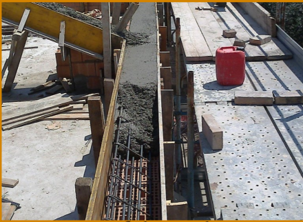
Getto del Calcestruzzo sopra l'Armatura
