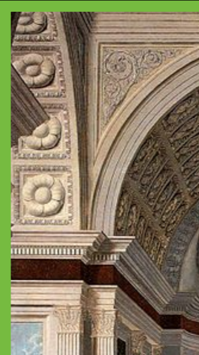
LA VOLTA A BOTTE È COSTITUITA DA UNA SERIE DI ARCHI A TUTTO SESTO POSTI IN PARALLELO
