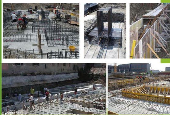
Posizionamento CASSERI e ARMATURE
