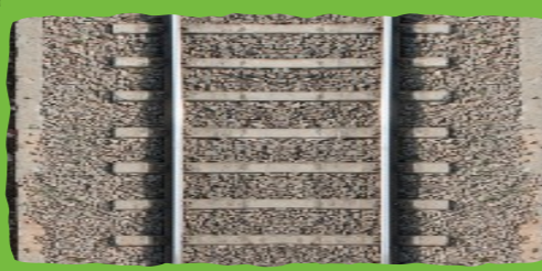
Binari di un treno elettrico
